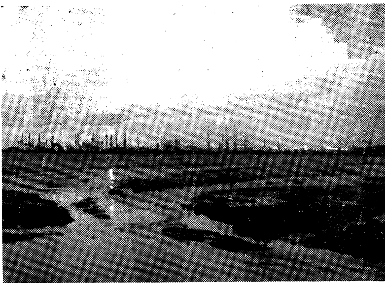
Um aspecto da Refinaria da SHELL, em Pernis (Holanda)
