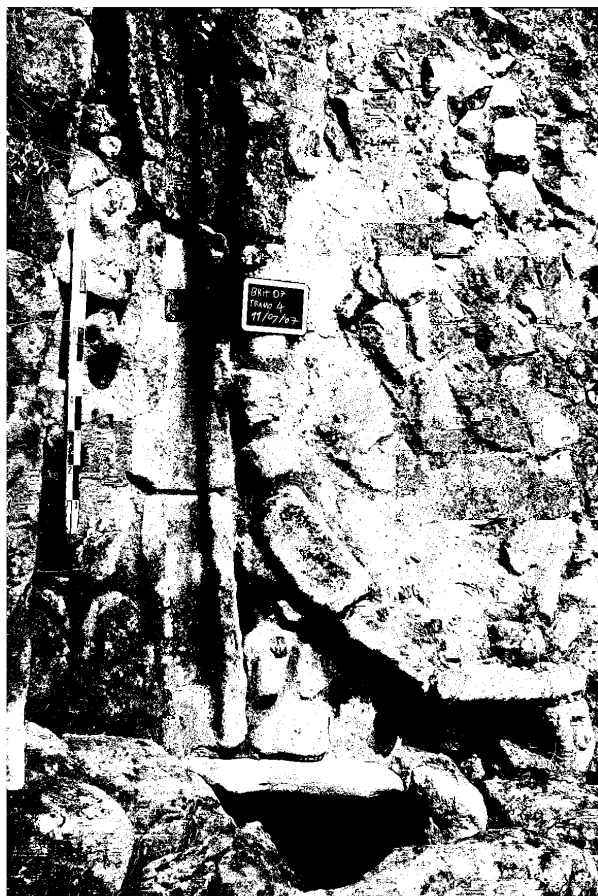
Imagem 15 - Um dos tramos da canalização da encosta nascente, limpo e fotografado na campanha de 2007.
