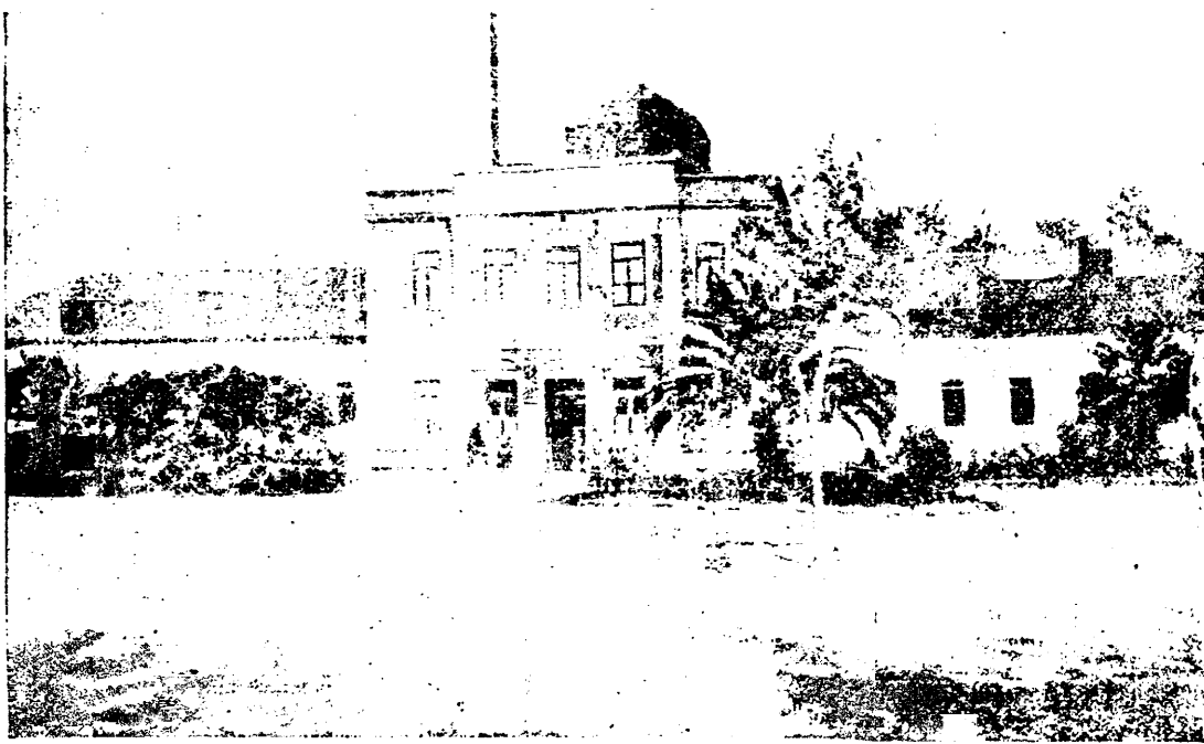
Balneário Novo, edificado em 1908
