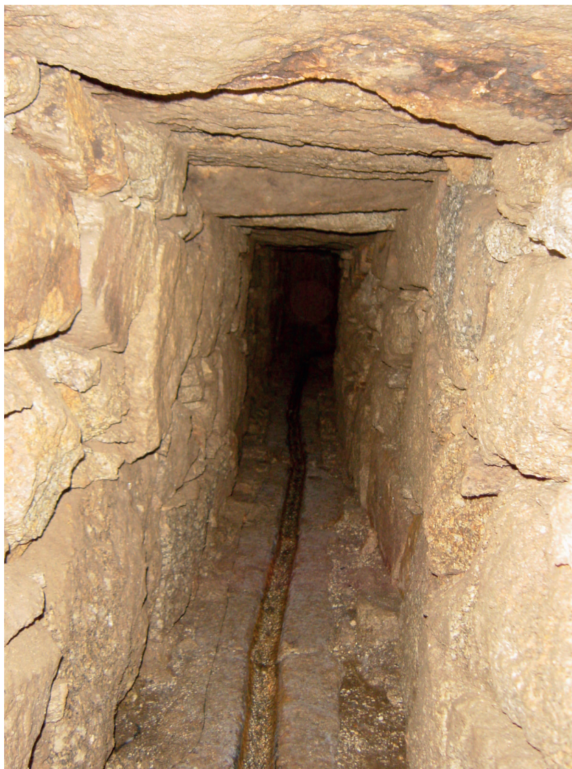
Figura 3 – Uma perspectiva da estrutura de abastecimento de água à cidade no Largo da Mumadona.
