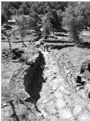
Figura 13 - Limpeza superficial na rua limite entre os sectores 8 e 12.
