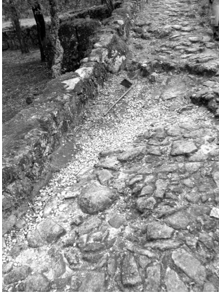
Figura 11 - Aspeto do troço de rua degradado antes da intervenção de reparação.
