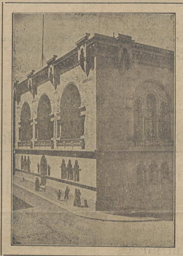
Edifício da Sociedade Martins Sarmiento
