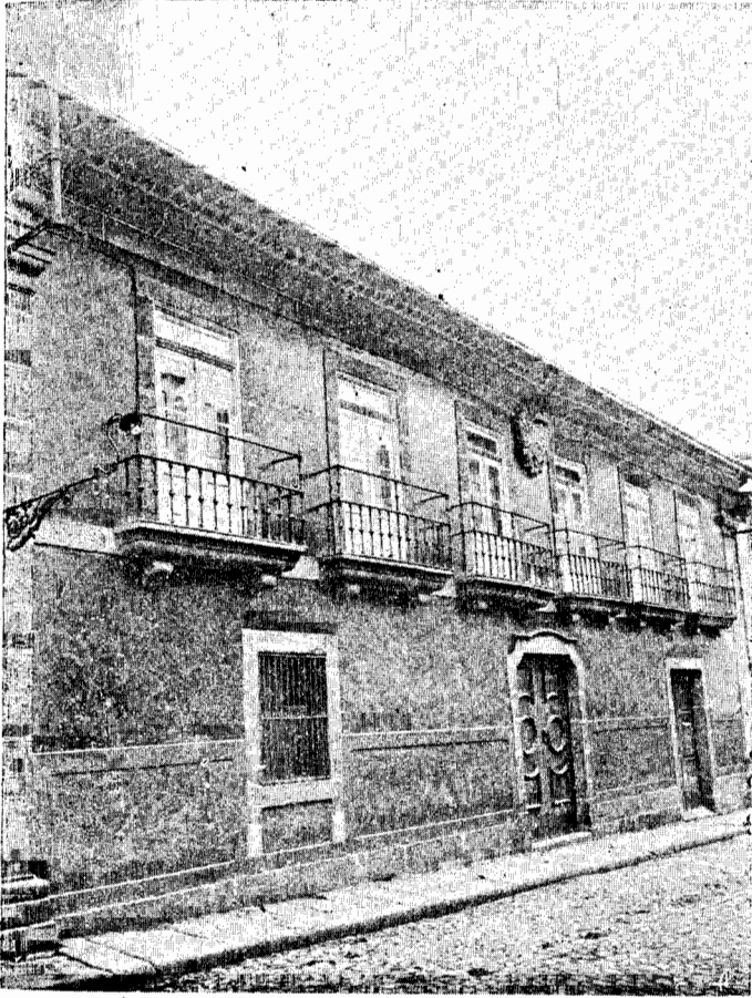
Casa do Conselheiro Lobato, na Rua da Caldeiroa. Fachada clássica, muito nobre e elegante.
