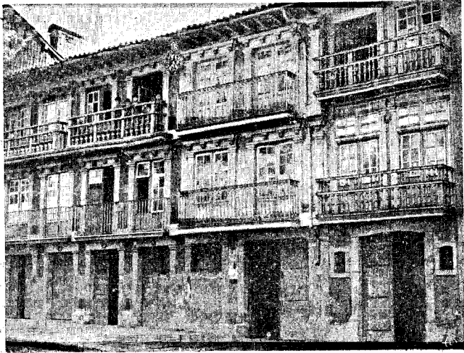
Fig. 4—Casas tabicadas, de beirais salientes, barroteados, da rua de Camões, de tipo frequente nos caracteres de construção.
