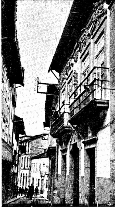
Prédio n.º 65, dos Rolas Perciras, na Rua de S. ta Maria.
