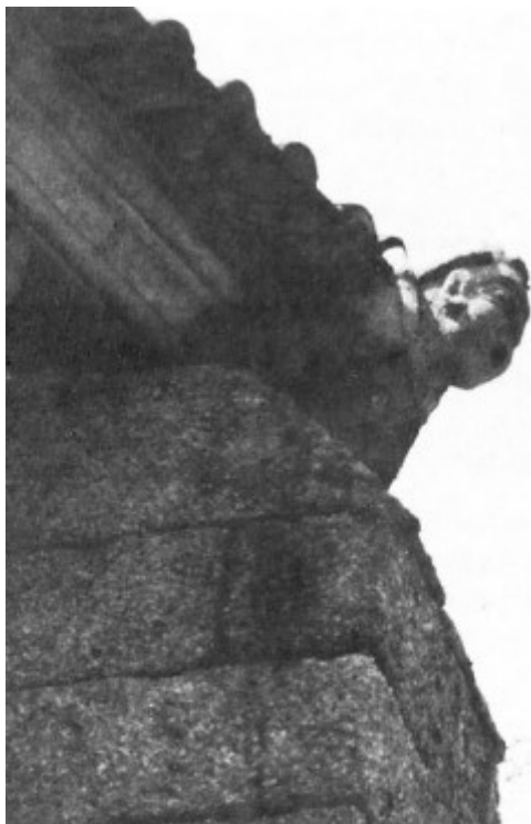
11. Gárgola del exterior del ábside. S. Francisco de Guimarães.
