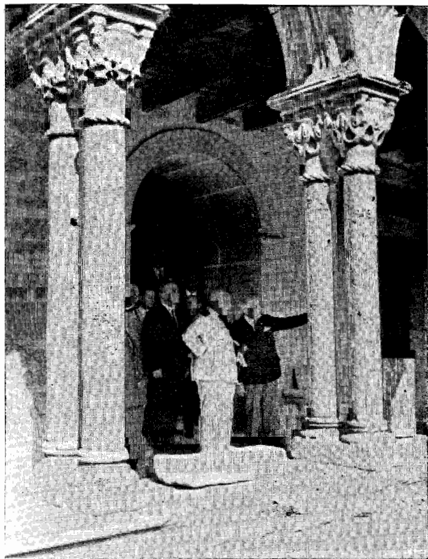
O Chefe do Estado no claustro gótico do século XIV, do antigo Mosteiro de S. Domingos, onde se encontra actualmente instalada a Secção de Epigrafia latina.
