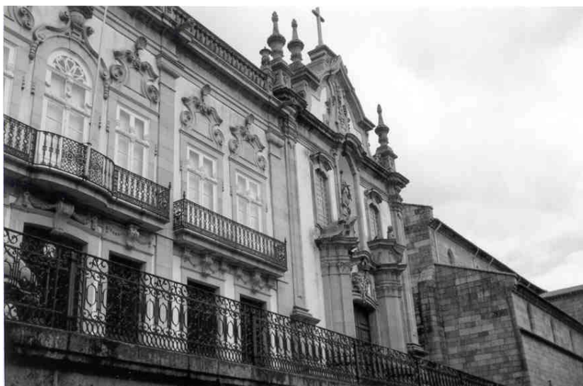
Foto 4 — Fachada da Venerável Ordem Terceira de S. Domingos
