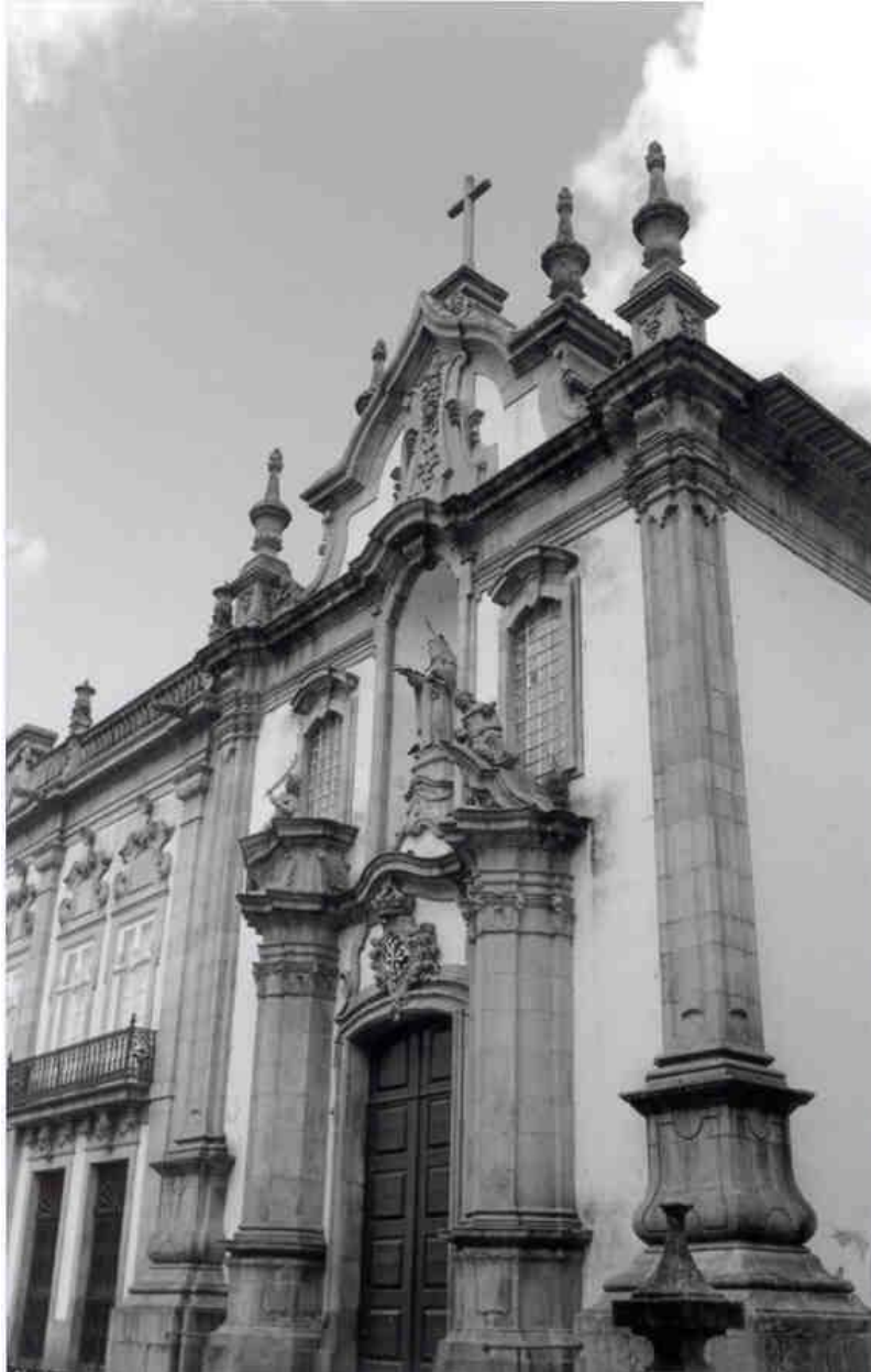
Foto 5 — achada da capela da Venerável Ordem Terceira de S. Domingos
