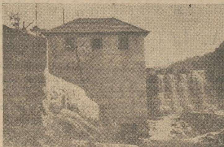
Central hidro-eléctrica da Fábrica do Moinho do Buraco
