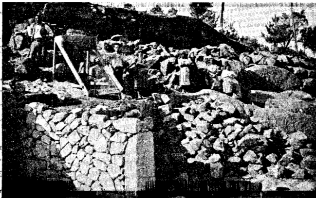
Fig. 2 — Pessoal empregado na crivagem das terras escavadas.
