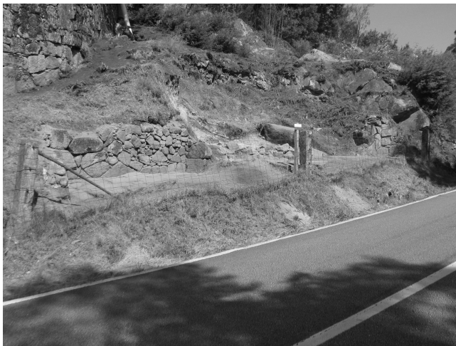
Fig. 4 – Perspetiva dos vestígios do Balneário Este no final da intervenção de 2016.
