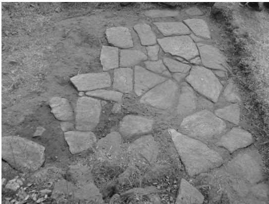
Fig. 11 – Aspeto do lajeado da "Casa de Auscus" após reposição das lajes retiradas.
