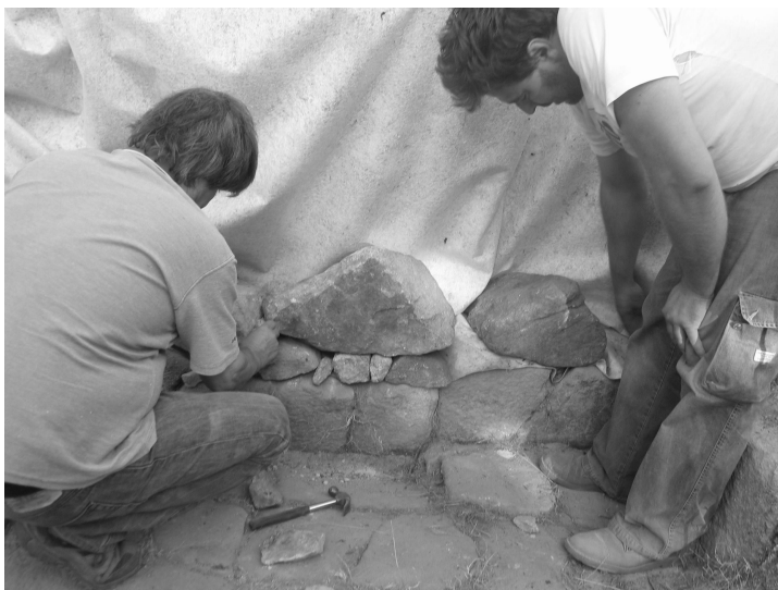
Fig. 3 – Reposição de elementos pétreos nos paramentos saqueados do Balneário Este.
