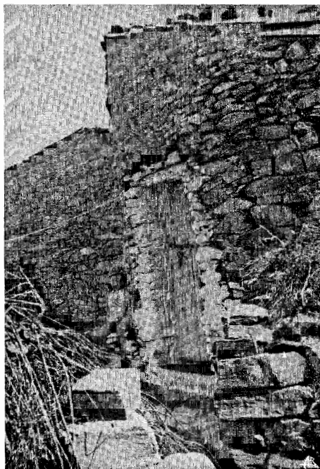
Fig. 1 — Casa de Álamo, de planta circular, actualmente habitada, pela Sr. a Rosalina Maria e seu marido, na qual se verifica a forma económica de caiação usada, e que é comum, também, no centro e norte da Beira-Baixa.
