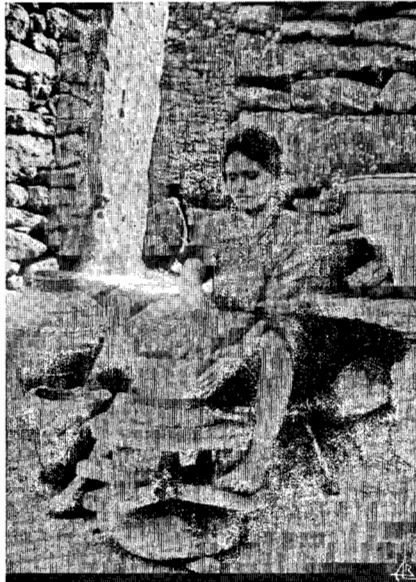
Fig. 12 — Aplicação dos rolos, por meio de «acrescentos», fazendo girar a roda com o pé esquerdo (MALHADA SORDA — ALMEIDA).
