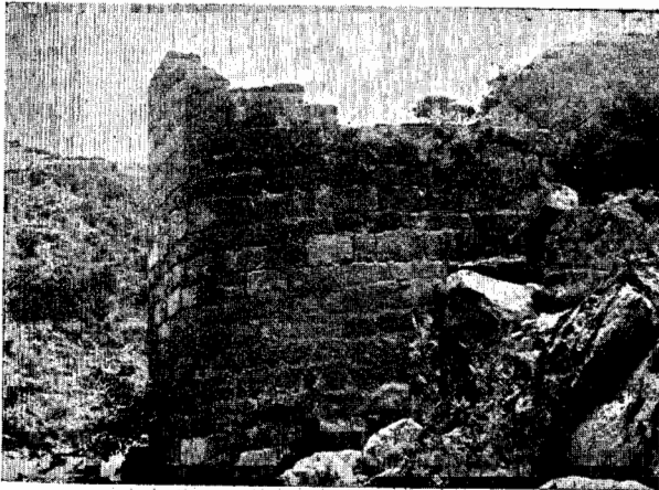
Fig. 16 — Ponte a jusante de Picões, sobre o Rabaçal ( margem esquerda )
