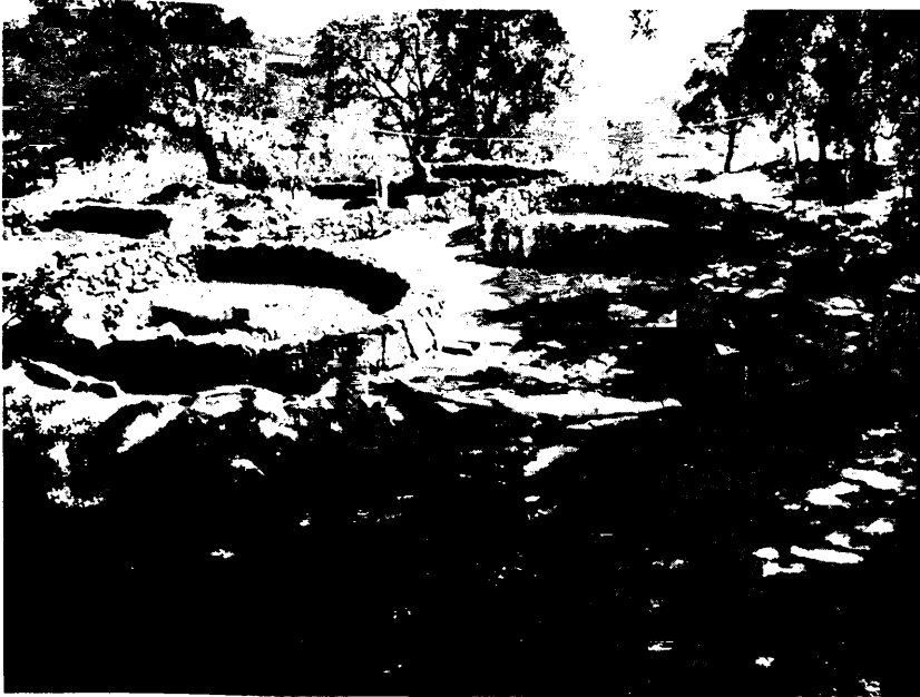
Imagem 4: Vista da Casa da Espiral, após a intervenção de 2005
